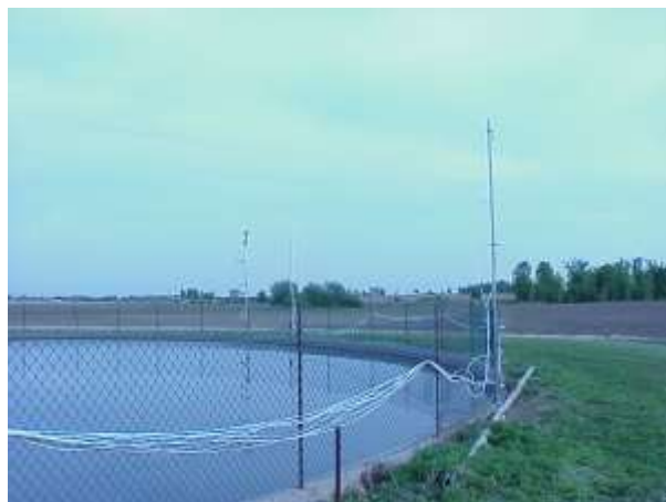
Betonsko spremište gnojovke (laguna)
